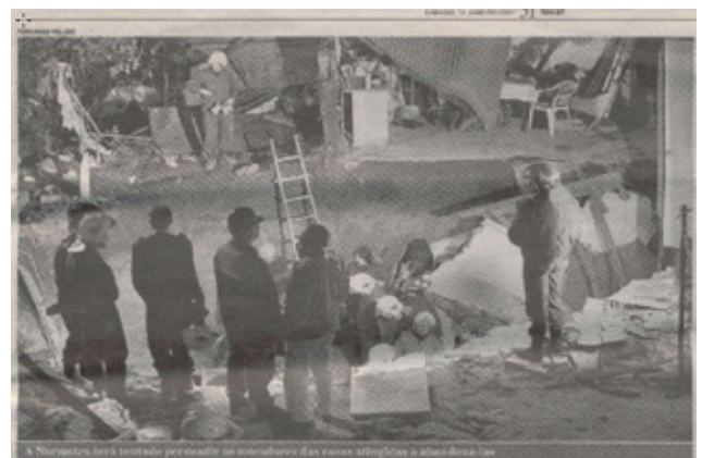
(a) Fontis apparu en surface.
