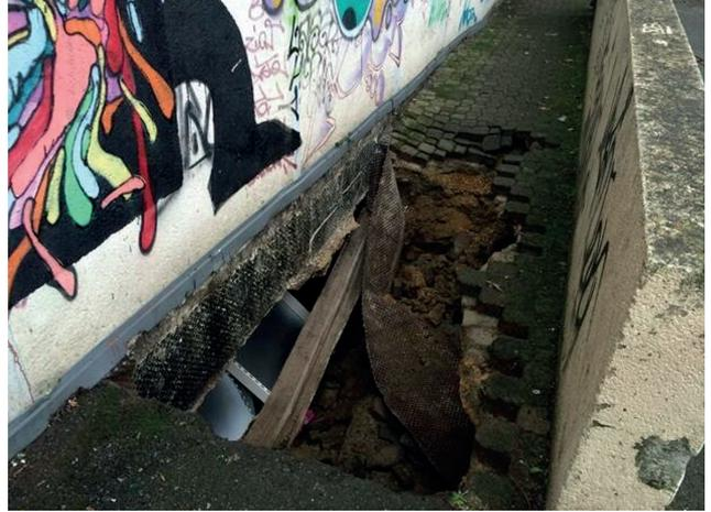
*Photographie du fontis apparu dans le magasin Noz. Celui-ci a une surface d'environ 20 m<sup>2</sup> et 3 m de profondeur. Trois personnes sont tombés dans ce fontis, mais ont pu s'en extraire sans gravité.
