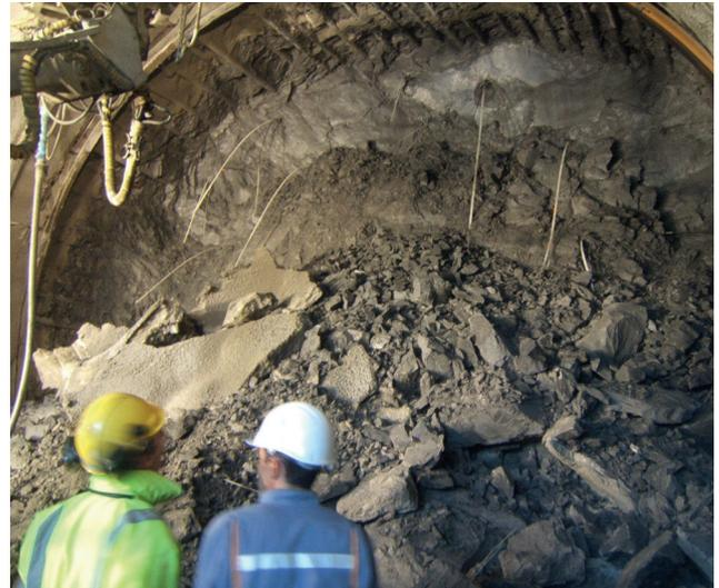
Vue du front après un des effondrements. Les boulons de front ainsi que la voûte parapluie sont clairement visibles.
