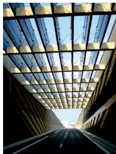
Photo 7: a phonic checkerboard (source: Les écrans acoustiques – Guide CERTU - 2007 - [16]) Illustration 14 : atténuation obtenue à l'aide d'un damier phonique (source : Les écrans acoustiques – Guide CERTU - 2007 - [16])
