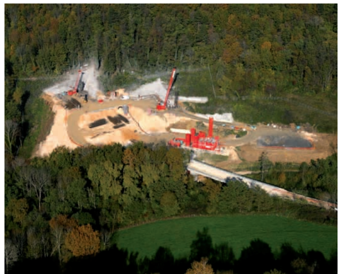
Photo 21 worksite at the Bois de Peu tunnel in Franche-Comté (source: CETU)
